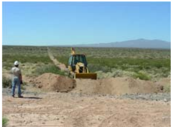
Máquina cerrando picada petrolera. Foto:Natalia Radovani.
